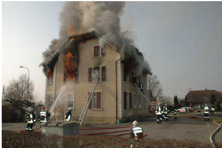
Brand Restaurant Bahnhof
